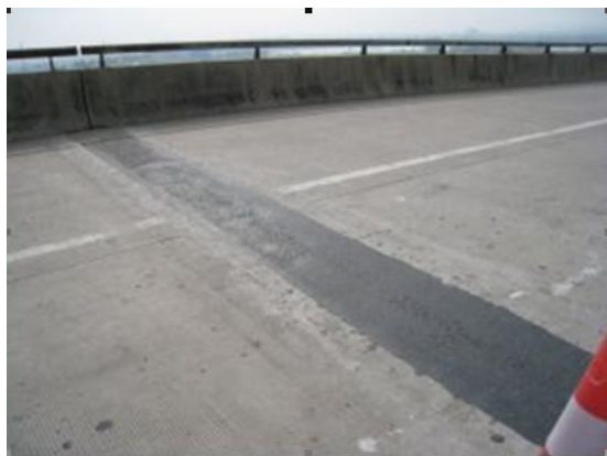
无缝式伸缩缝
