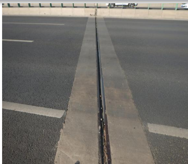
异型钢单缝式伸缩缝
